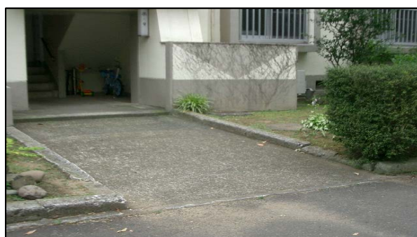
北側4 m道路の棟の出入口 1・2・3・8・9号棟
